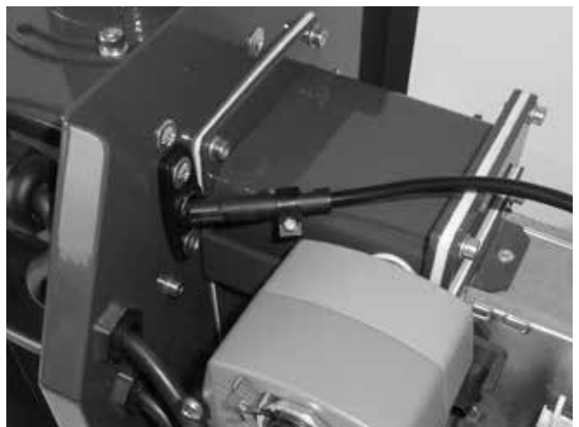
Abb. 6 - Photozelle - Vorsicht auf richtige Ori- entierung – es wird empfohlen, die Zelle mindes- tens einmal jährlich zu reinigen
