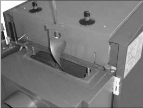
Den Turbulator bei der Reinigung herausnehmen
