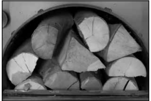
Die richtig befüllte Kammer im Detail
