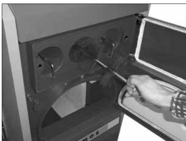
Reinigung des Wärmetauschers (Rohrwand) mit der beigelegten Bürste (bei den Kesseln P20, P30, P40, P50)
