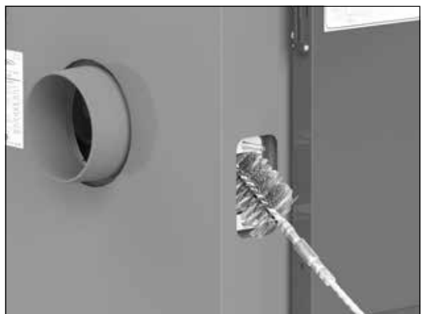
Vorführung der Reinigung des Rauchkanals. Wird nach Reinigung des Rohrbündels in Verbrennungskammer des Kessels durchgeführt
